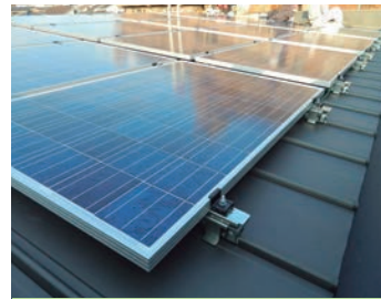
パネル設置完了
