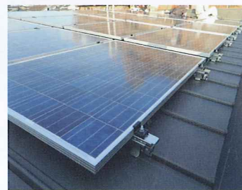
パネル設置完了
